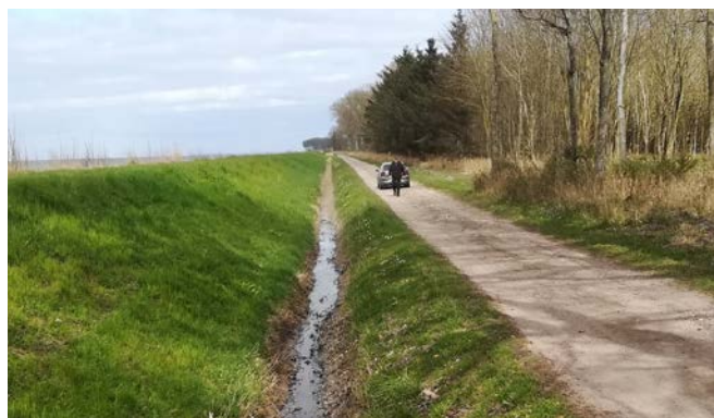
Dige med sti og grøft Foto: Schönherr
