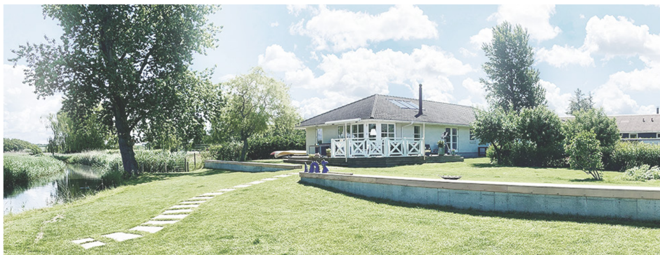
Højvandsmur/opholdskant i have ved Værebros Å, Jyllinge Foto: Bayo.s
