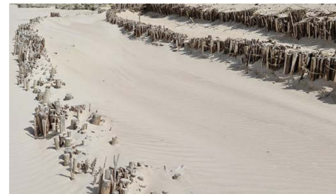
Biologisk kystsikring med pilefelt udført af GroundPlug International i Nr. Lyngby Foto: Carsten Agerup
